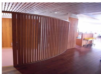
T小学校の間仕切り壁
