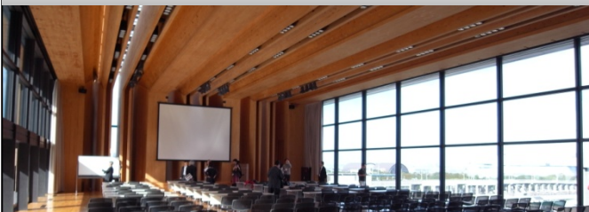
<写真：7 階ホール 24m スパンの天井梁>
